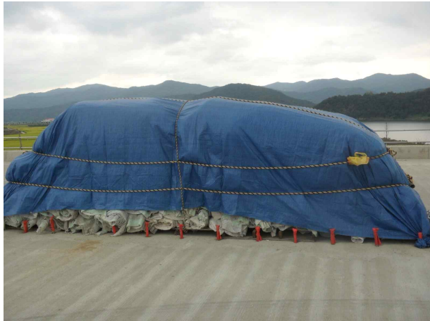
의상대교 현장 주변 철근 관리상태
